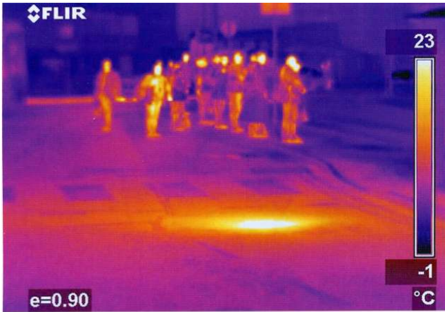
La perdita in una tubazione viene facilmente identificata dalla termocamera
